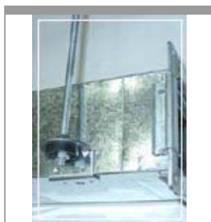
Фото 1.1. Крепление при помощи Z-образного профиля и шпильки
