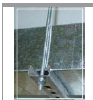
Фото 1.3. Крепление при помощи траверса и шпильки
