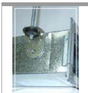
Фото 1.2. Крепление при помощи L-образного профиля и шпильки
